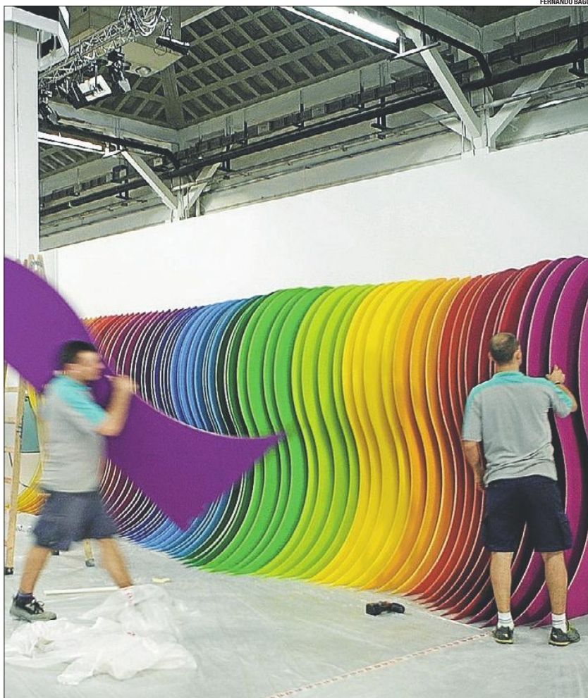
Los operarios trabajan en el montaje de un stand de The Brandery, el pasado viernes.
